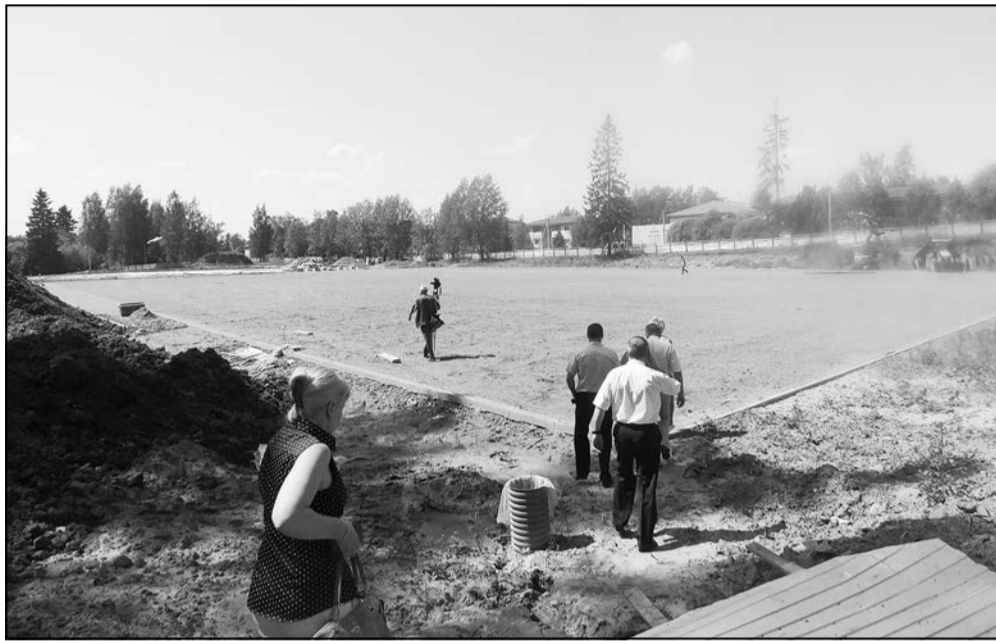
Строительство площадки у школы №3 в сиверском, 5 июня 2014 года.
